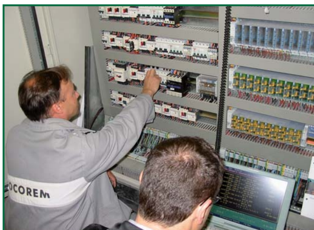
Un chantier à Purpan.
